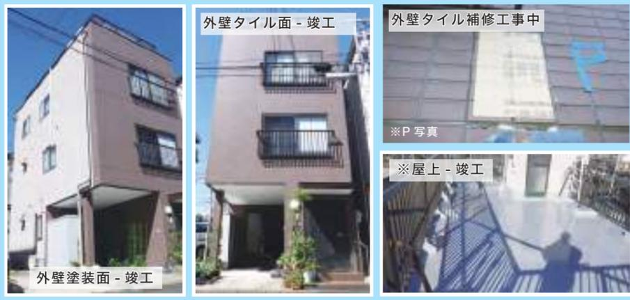
今回は屋上防水塗替え、外壁塗装塗替え、外壁タイル部分補修工事をさせて頂きました。外壁の色を決めるのにお客様からのご要望が原色に近い明るい色を希望されておりましたので見本を作成して工事を進めて参りました。タイル面の補修工事は、(※P写真)タイルの浮き部を剥して下地調整をした上でタイル張りを行います。※屋上は物を撤去し、防水工事をし、スッキリ広々と綺麗になりました。工事中にはご近所よりとても丁寧な仕事をされているとお褒めのお言葉を頂き、また完了後も新築したみたいと言って頂いてお客様も大変喜んでおられました。お客様、ご近隣の皆様の御協力に感謝申し上げます。今後ともお客様に信頼され喜んで頂ける仕事をしていきますので、どうぞよろしくお願い致します。
