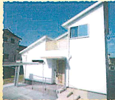
区画No.48-5 白木建設
