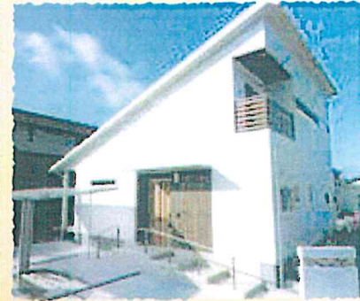
区画No.48-6 白木建設
